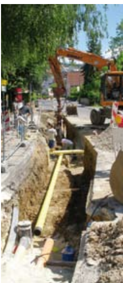
Sanierungsarbeiten in der Neuen Straße
