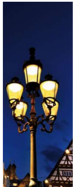
Erneuerung von 7.000 Straßenlampen
